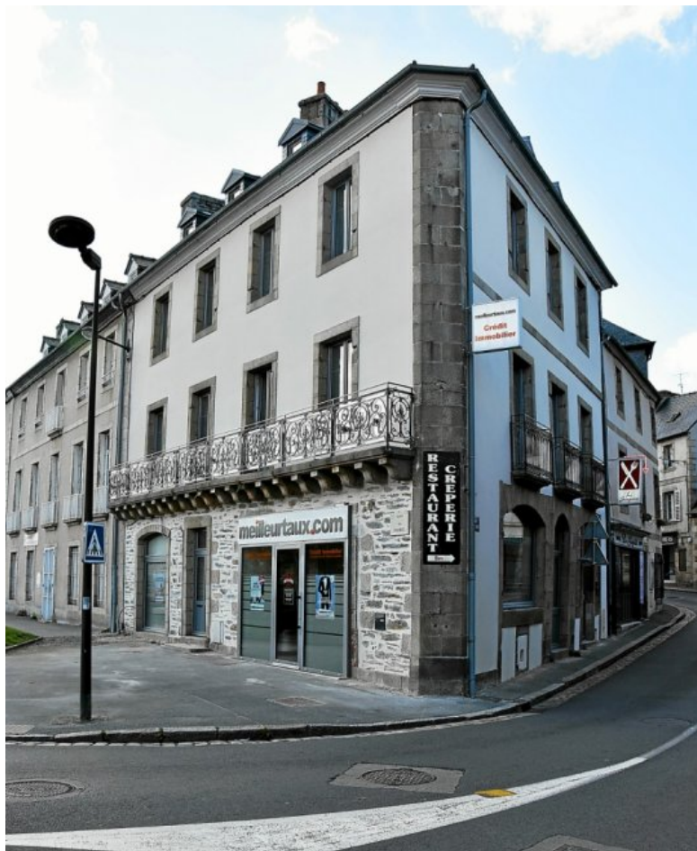
Le 1 er quai des Viarmes, après les travaux. (Éric Rannou)
