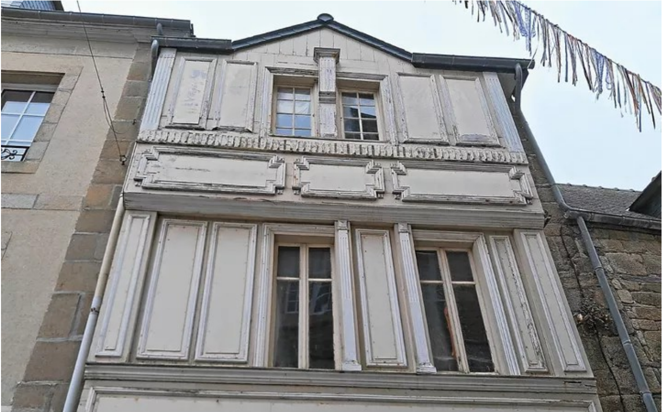
La façade à pans de bois, sous coffrage, de l'immeuble du 3, rue de Saint-Malo à Lannion. (Le Télégramme/ Mael Moizant)
